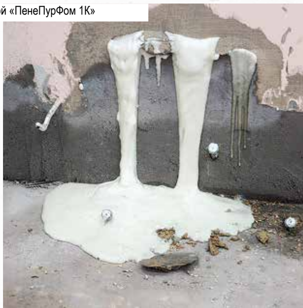
Инъектирование смолой «ПенеПурФом 1К»
