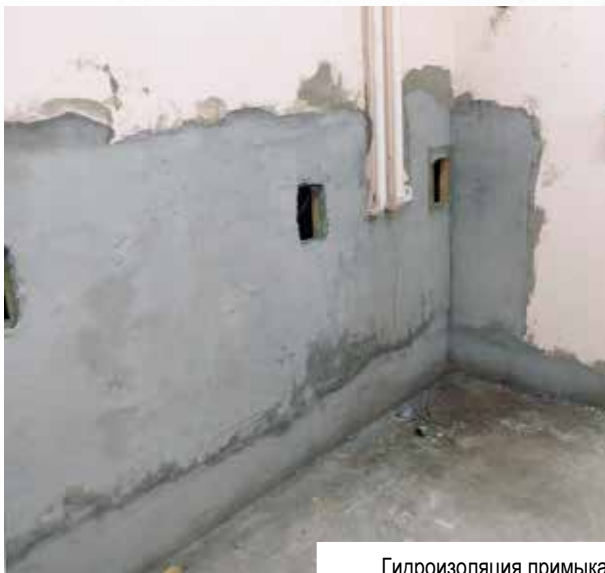
Гидроизоляция примыканий пола с кирпичной стеной
