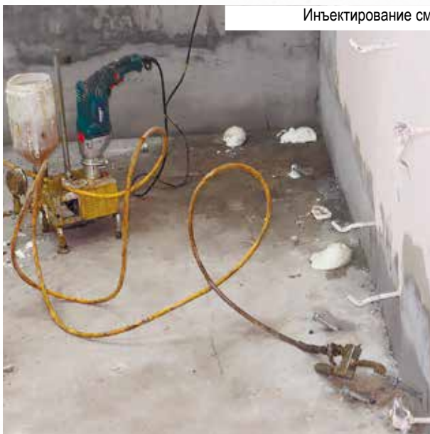
Инъектирование смолой «ПенеПурФом 1К»
