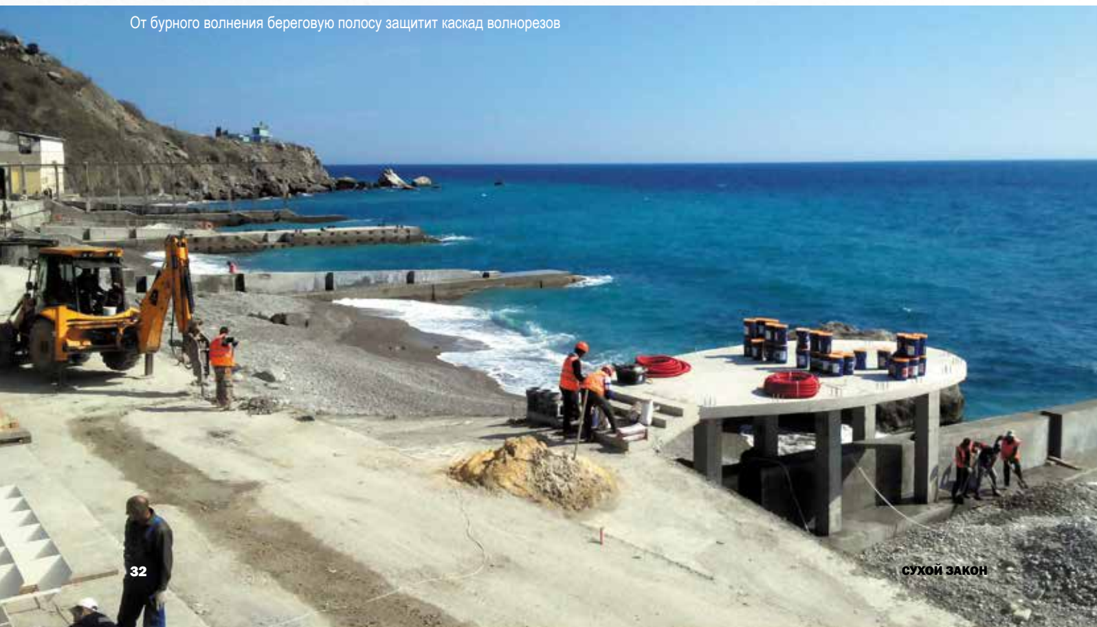
Гидроизоляция волнорезов
