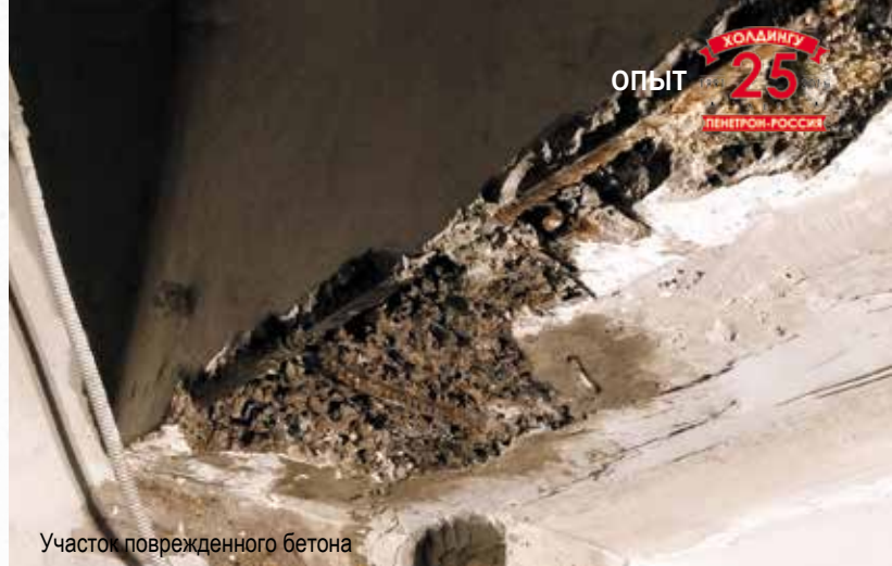
Подготовка поверхности для применения материалов Пенетрон
