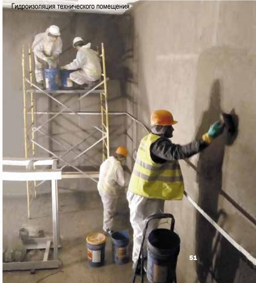
Гидроизоляция технического помещения
