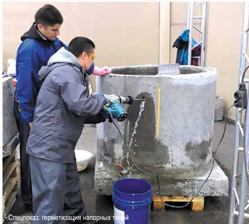
Гидроизоляция методом инъектирования
