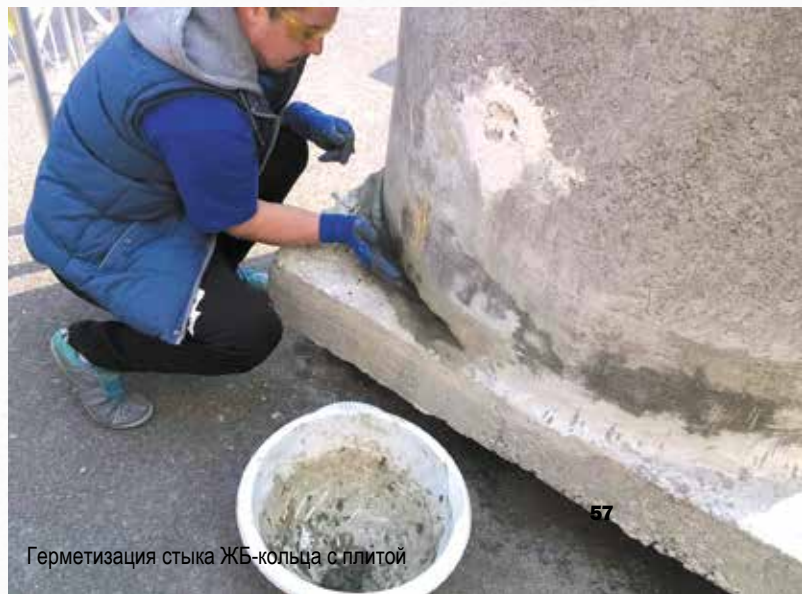
Спецпоказ: герметизация напорных течей
