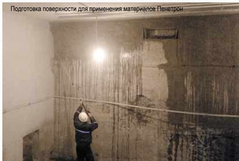
Гидроизоляция технического помещения
