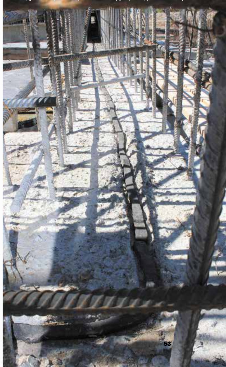
Гидроизоляция холодных швов с гидропрокладкой «Пенебар»
