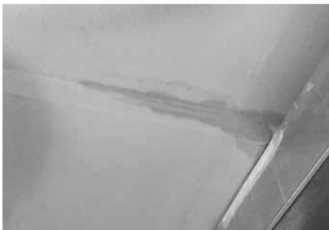
До начала работ
