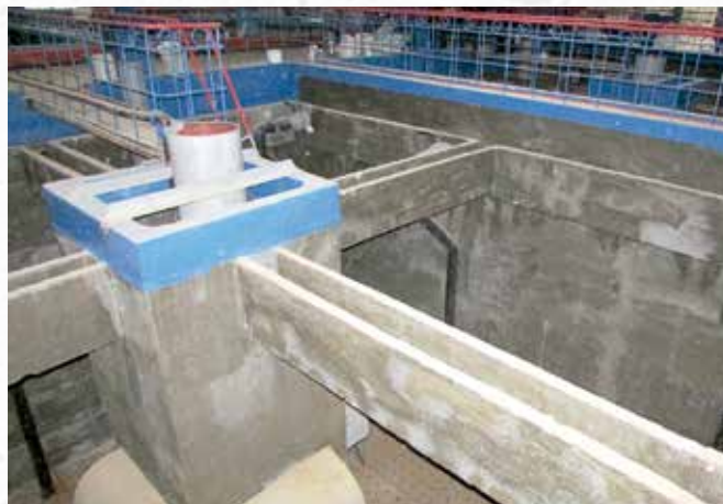
По окончании работ
