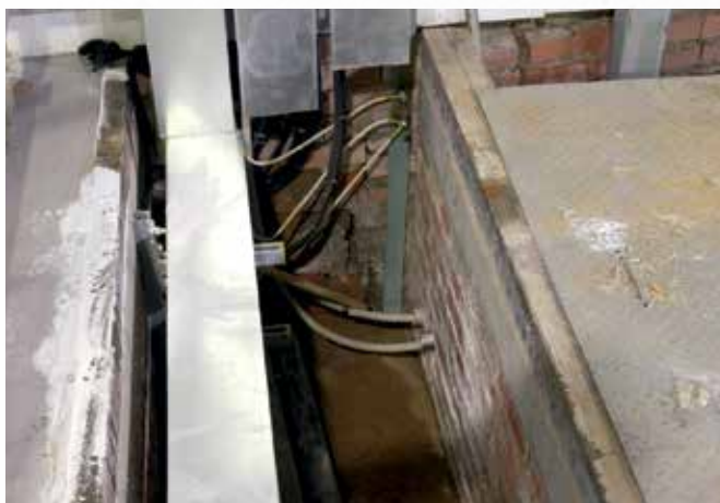
До начала работ
