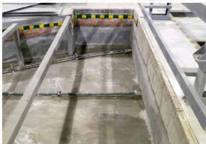
По окончании работ
