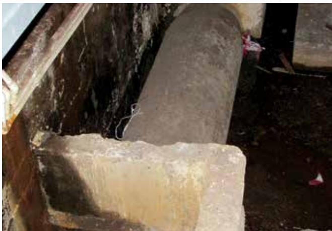
До начала работ
