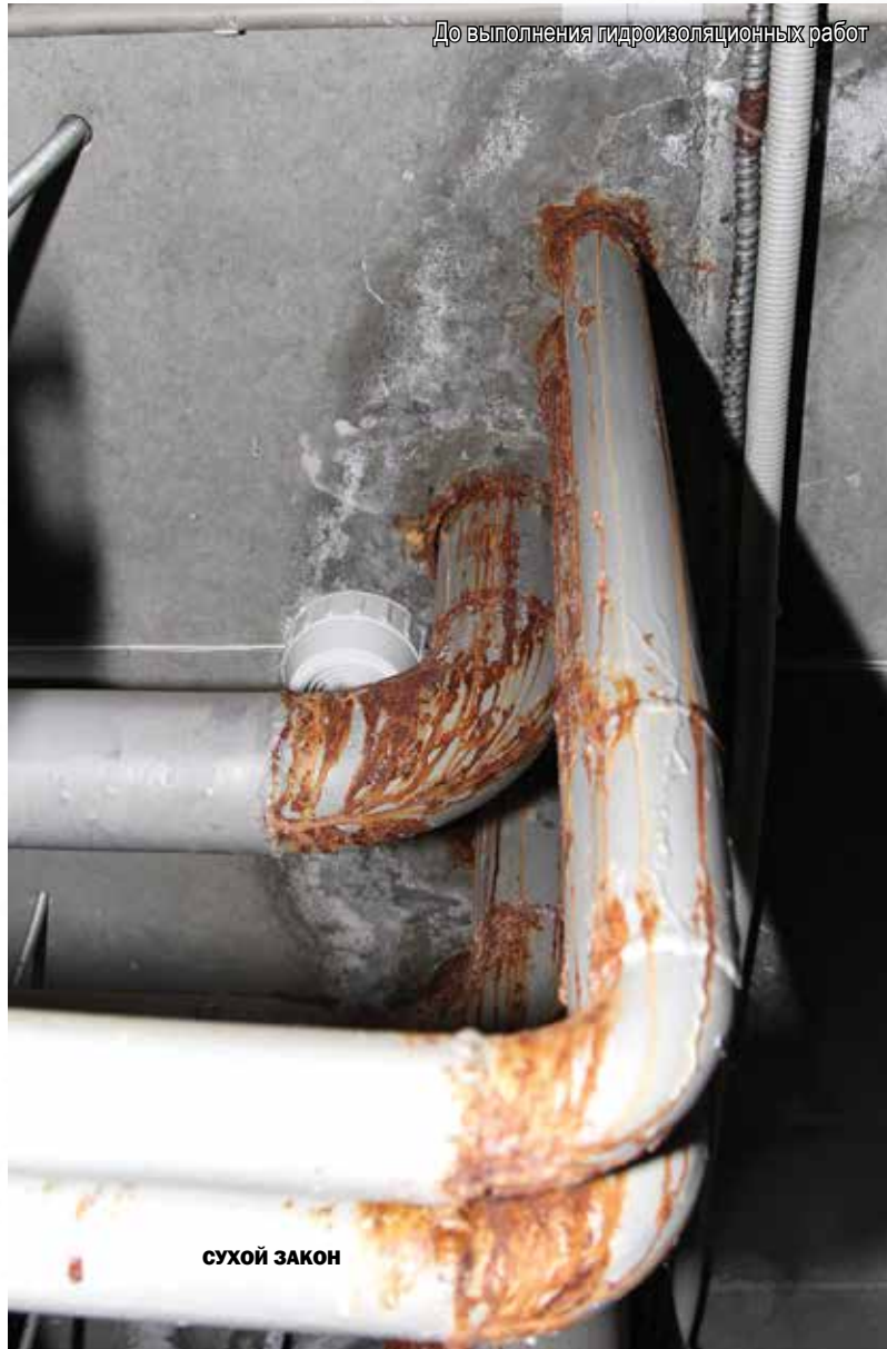
Гидроизоляция мест ввода инженерных коммуникаций
