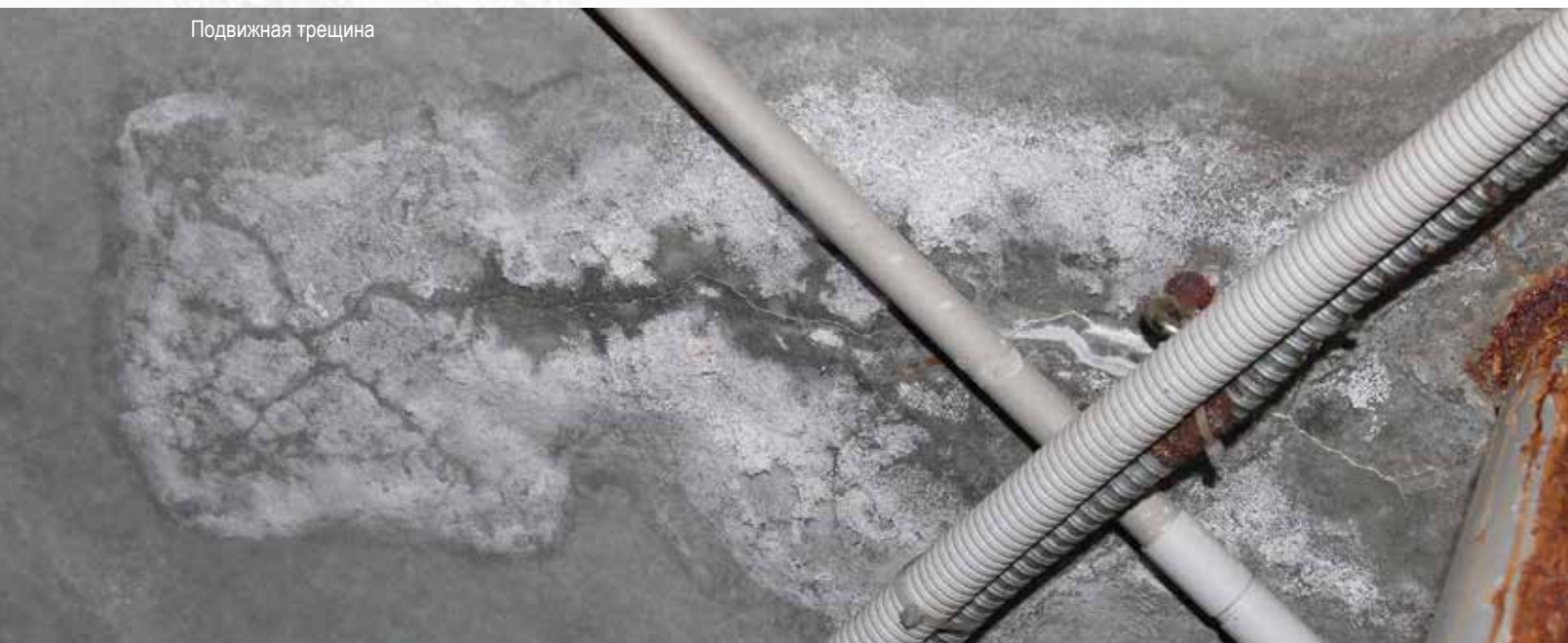
Гидроизоляция подвижной трещины
