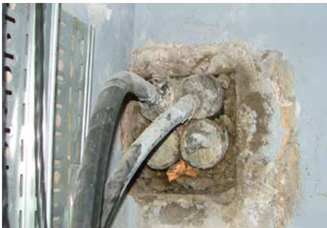
До начала работ
