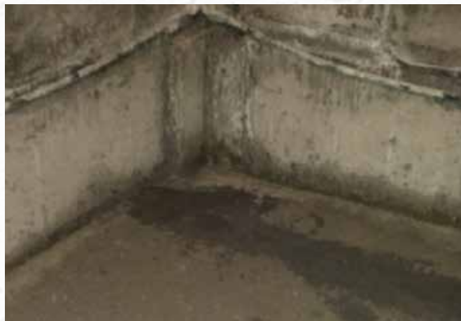
По окончании работ
