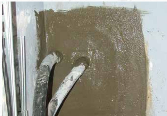
По окончании работ
