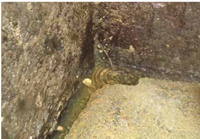
До начала работ
