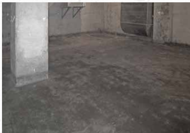
По окончании работ
