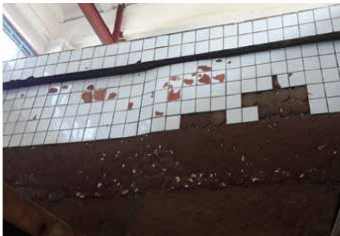
До начала работ
