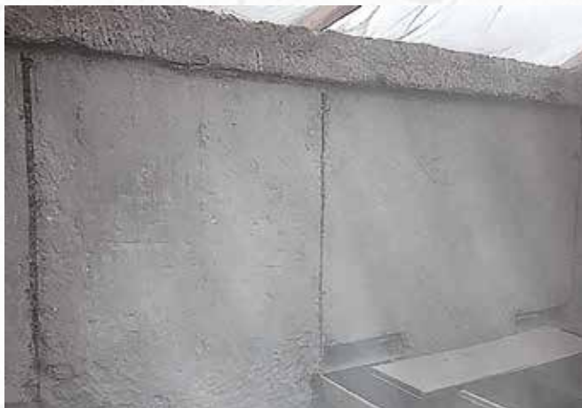
По окончании работ
