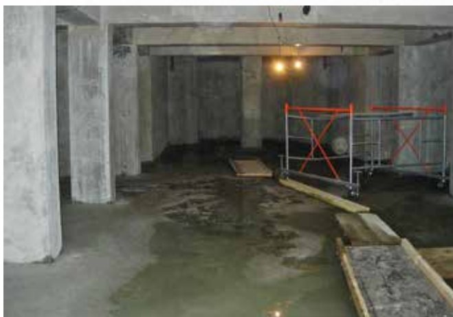
До начала работ
