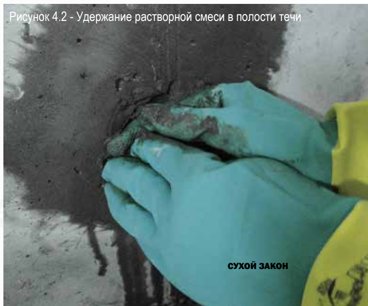
Рисунок 4.1 - Остановка течи
