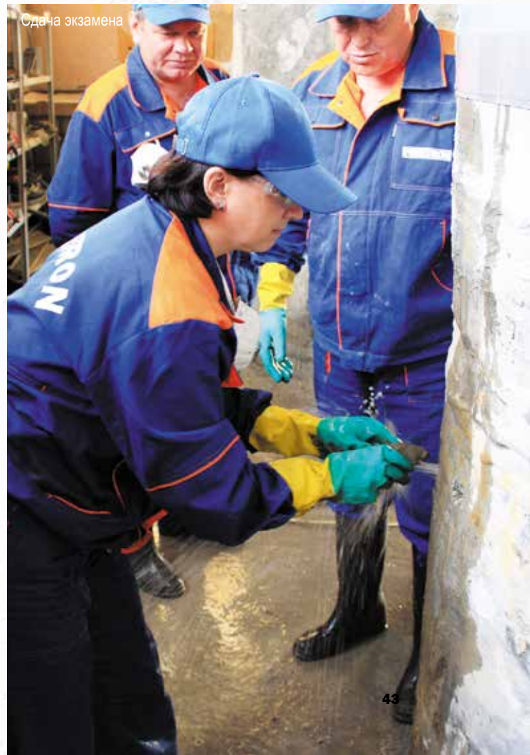
Гидроизоляция шва бетонирования
