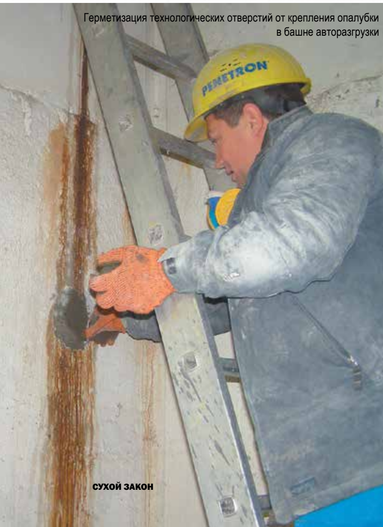
Остановка напорных течей по рабочим швам бетонирования в норийной башне
