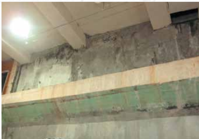
По окончании работ
