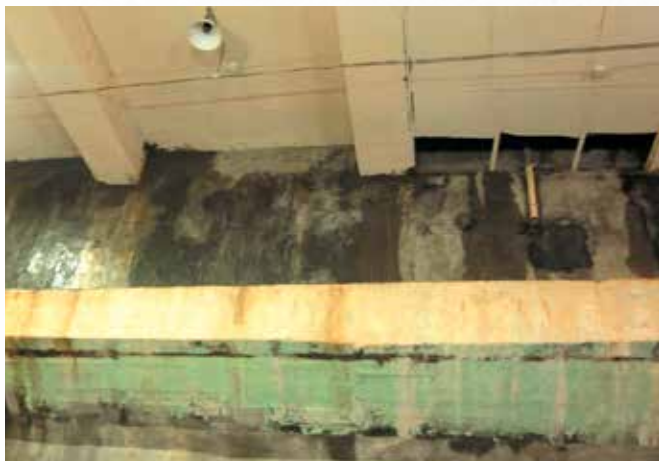
До начала работ
