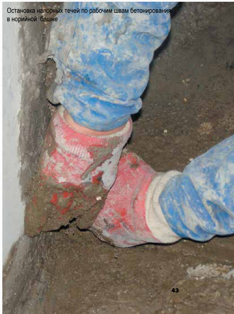
Герметизация технологических отверстий от крепления опалубки в башне автотрузки
