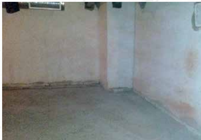
По окончании работ
