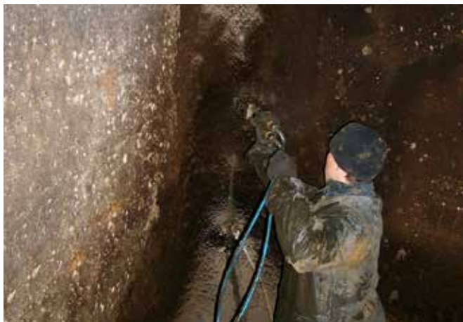
До начала работ
