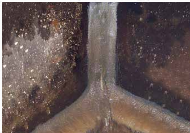
По окончании работ
