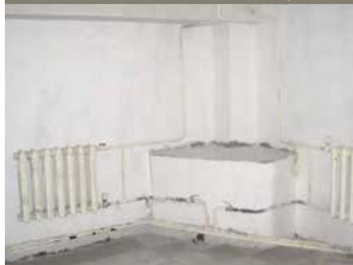
При детальном осмотре объекта выяснилось, что в реставрации нуждаются не только железобетонные конструкции. Для гидроизоляции кирпичных участков стен использовался ремонтный состав «Скрепа М500», который отлично справился со своей задачей.
