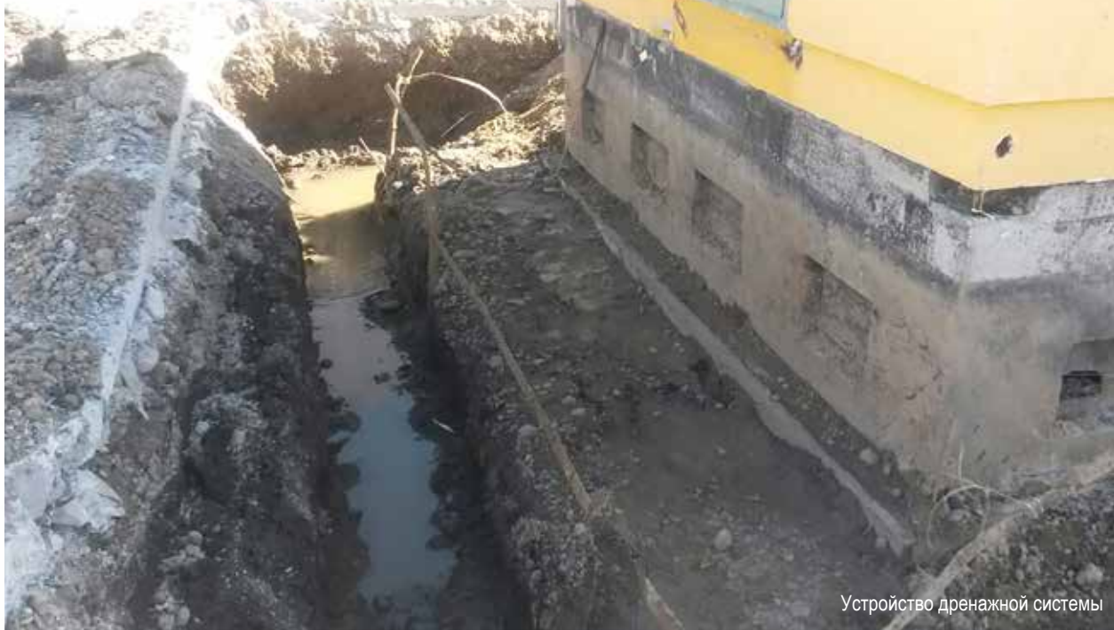
Устройство дренажной системы и гидроизоляция вводов коммуникаций
