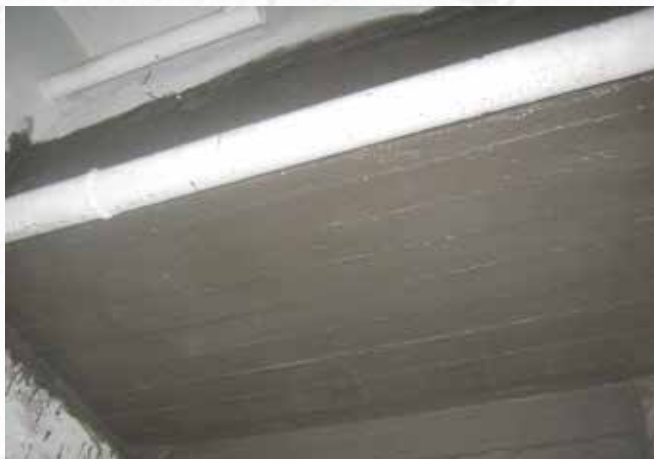
По окончании работ
