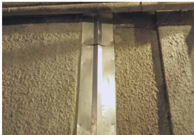
По окончании работ
