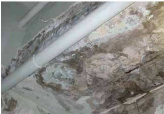
До начала работ
