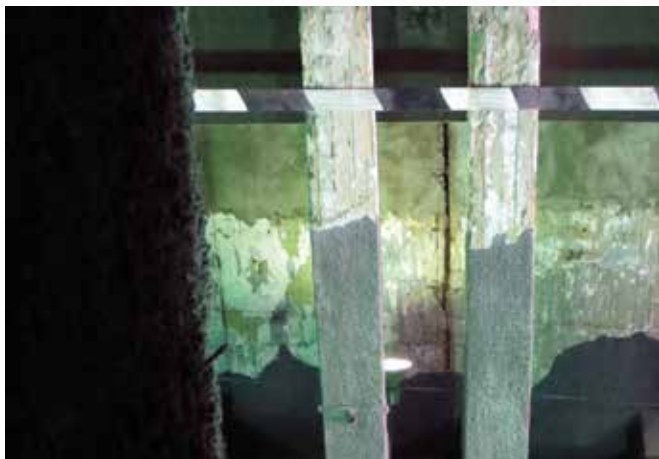
До начала работ
