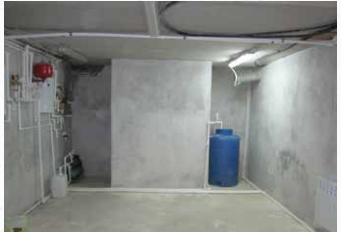
По окончании работ
