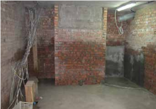
До начала работ
