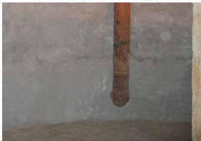
По окончании работ
