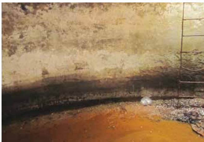
До начала работ
