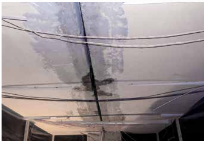
До начала работ
