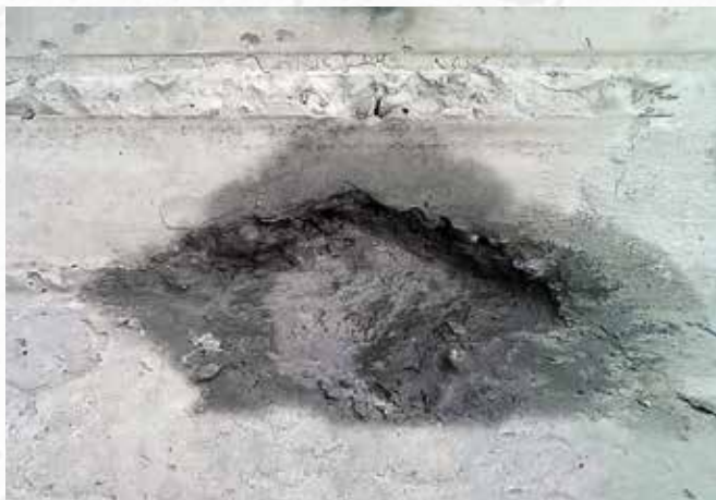
По окончании работ
