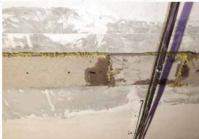
По окончании работ
