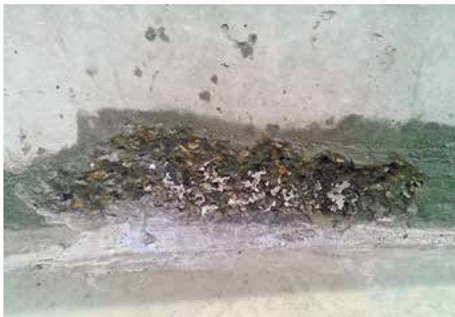
До начала работ
