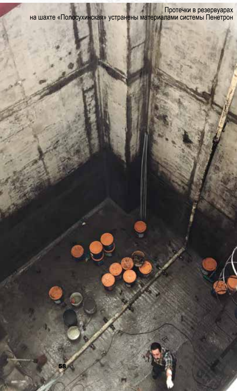
Из резервуара очистных сооружений на шахте «Полосухинская» утекало 50 м 3 воды в сутки
