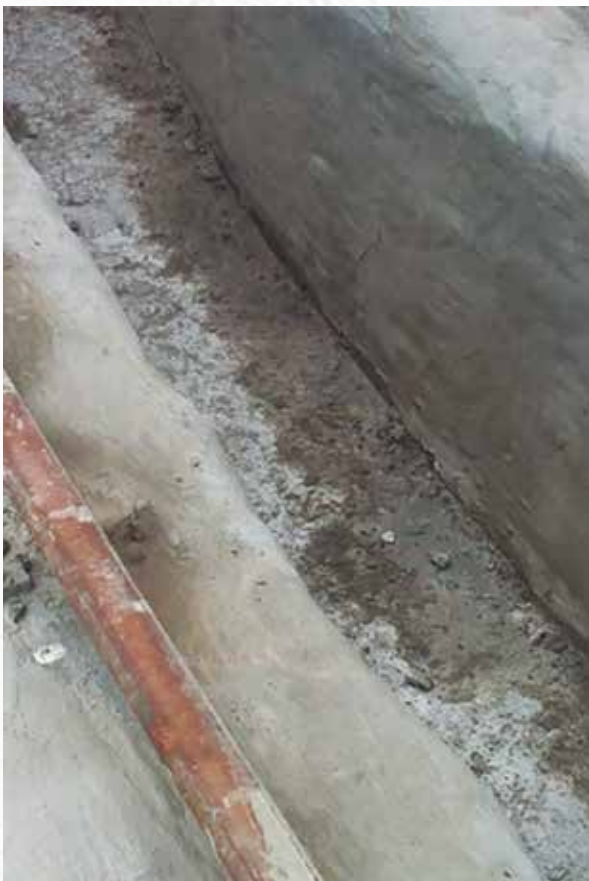
Рисунок 5. Вид конструкции после восстановления защитного слоя
