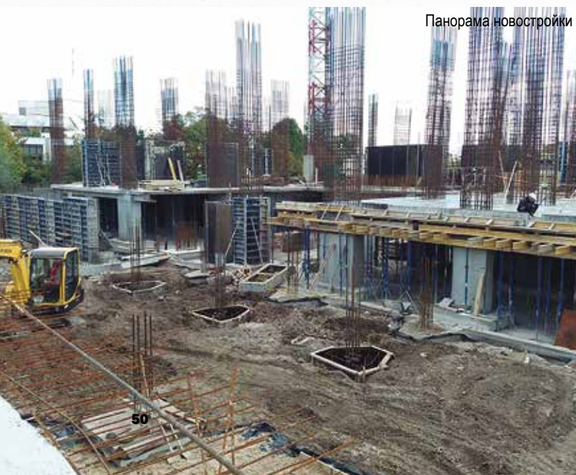
С добавкой «Пенетрон Адмикс» залит фундамент будущего здания апартамент-отеля № 1
