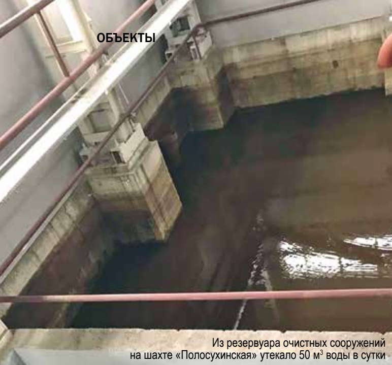
Протечки в резервуарах на шахте «Полосухинская» устранены материалами системы Пенетрон
