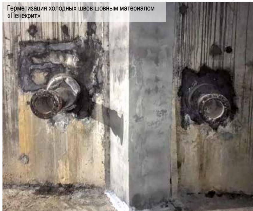
Гильза загерметизирована с применением материалов: «Пенебар», «Пенеплаг», «Пенекрит», «Пенетрон»
