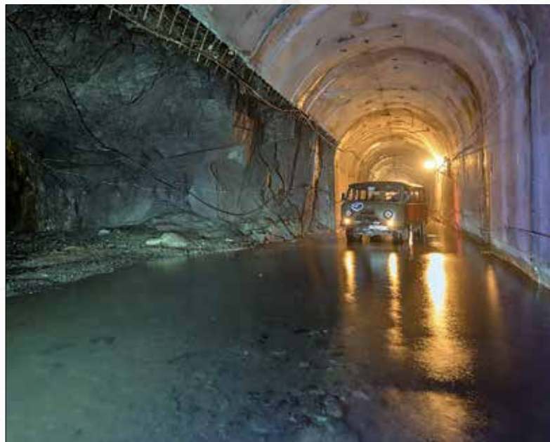
В деривационном тоннеле перед началом работ
