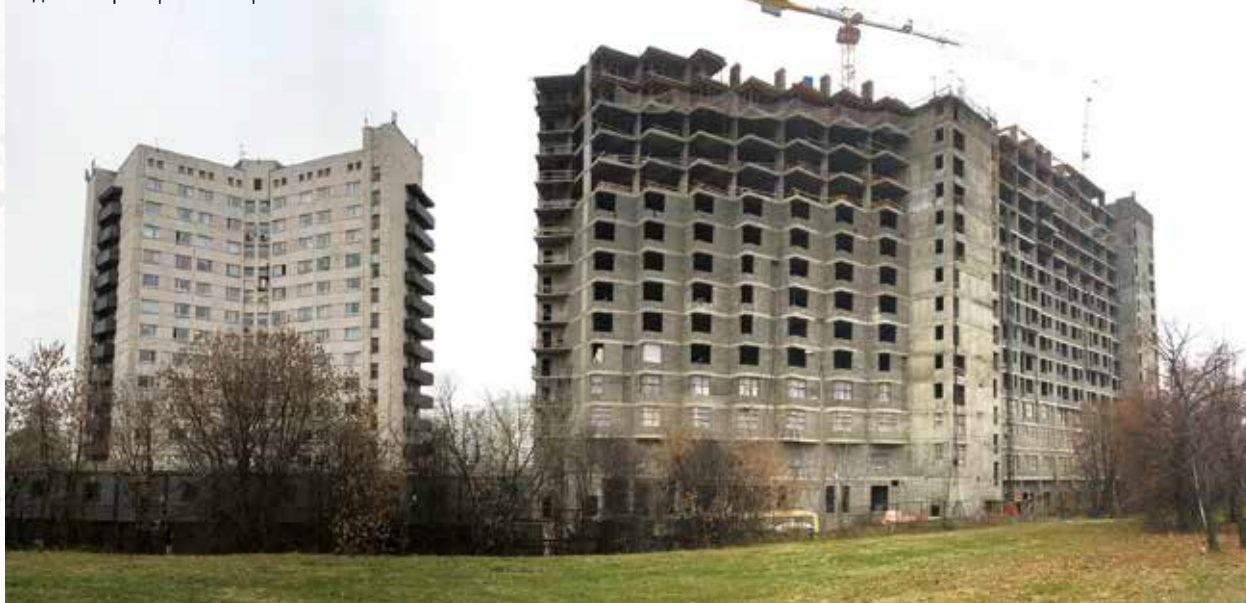
Здание строящегося общежития МГИМО
