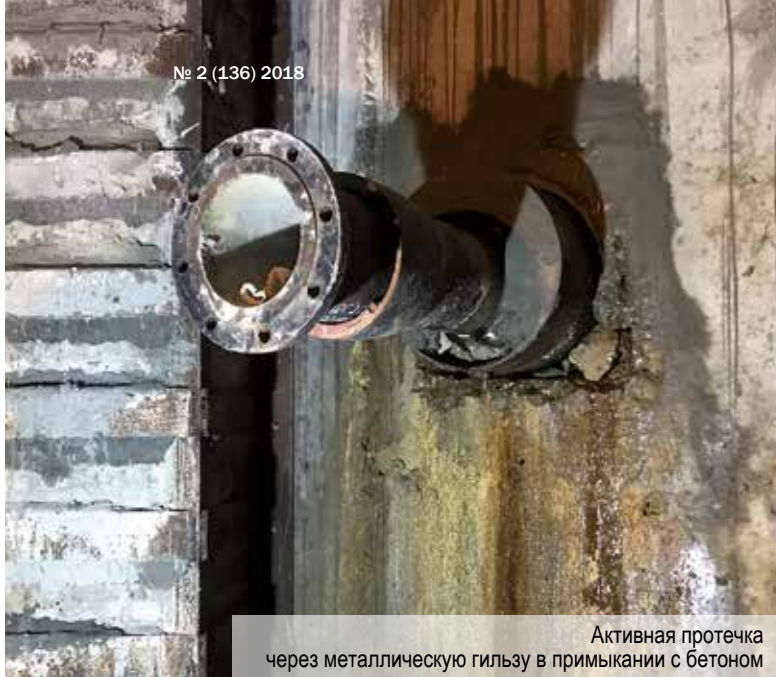
Активная протечка через холодные швы технологического проема и металлическую гильзу
