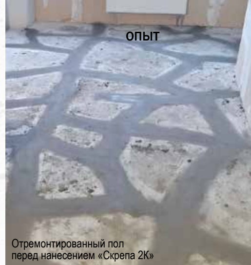
Заполнение составом «Скрепа М700 Конструкционная»
