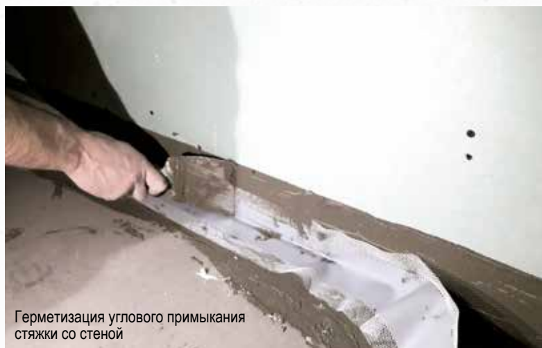
Заполнение составом «Скрепа М700 Конструкционная»
