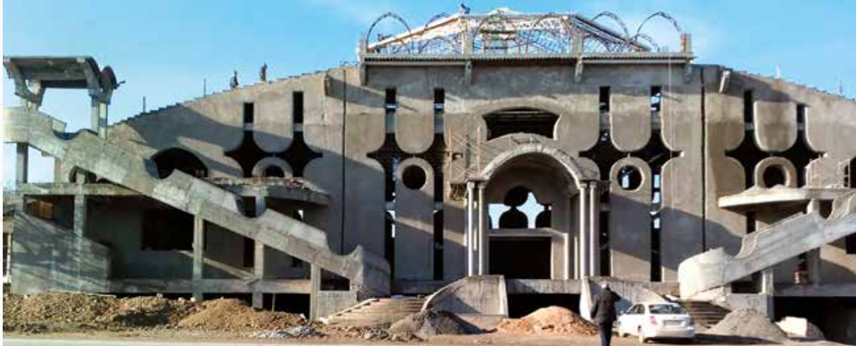
На строительстве свадебного ресторана в Самарканде
