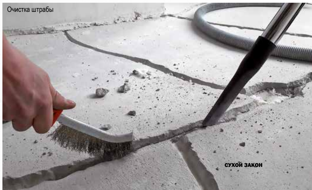
Расшивка трещин в стяжке пола
