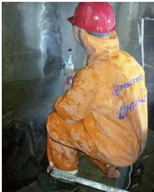
Работы начинались с восстановления гидроизоляции швов
