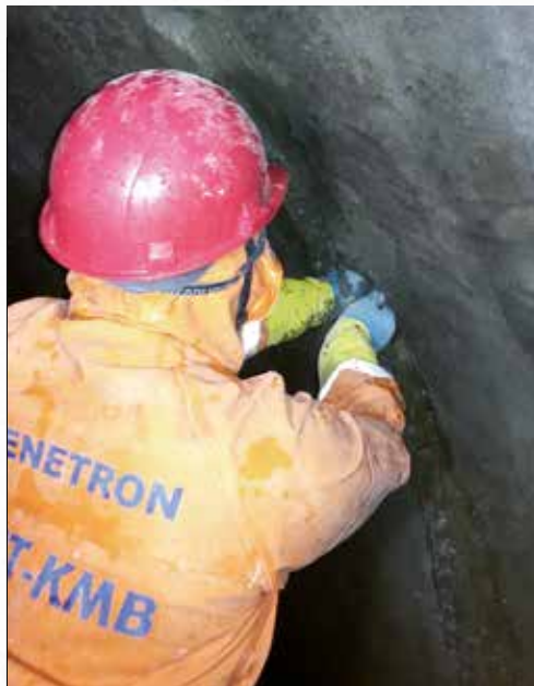
Заделка шва материалом «Пенекрит»
