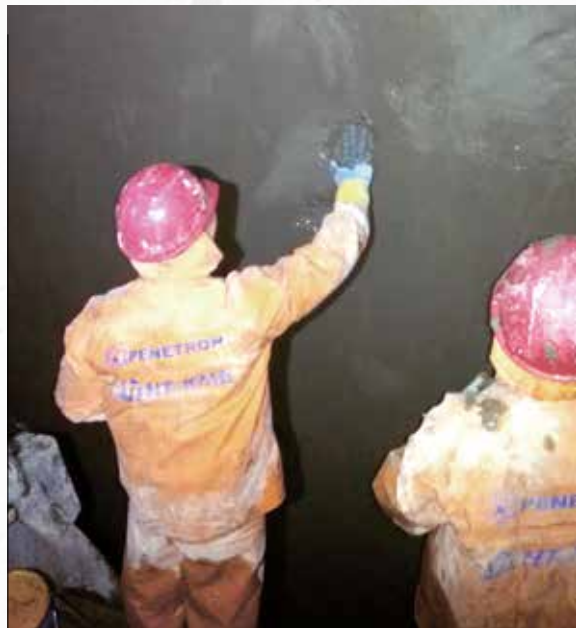
Восстановление поверхности составом «Скрепа М700 конструкционная»
