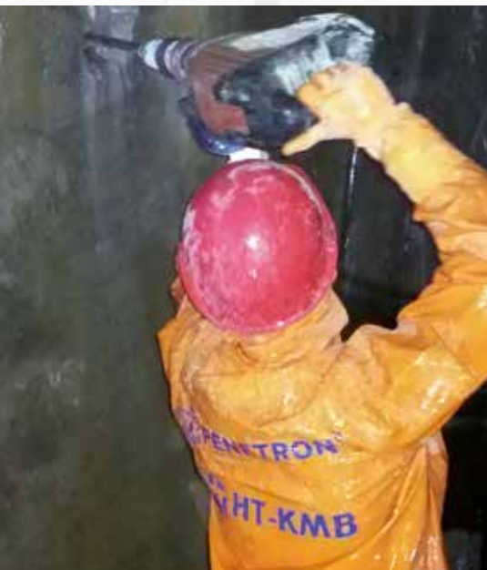
Разбивка дренажных трубок
