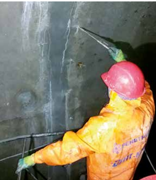
Инъектирование шва смолой «ПенеСплитСил»
