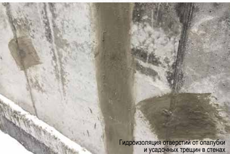
Подвал ЖК «Эверест»
