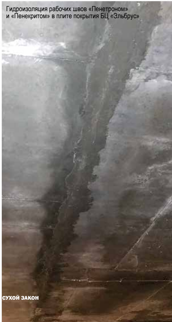
Инъектирование трещин смолой «Пенесплитсил» в плите покрытия в БЦ «Эльбрус»
