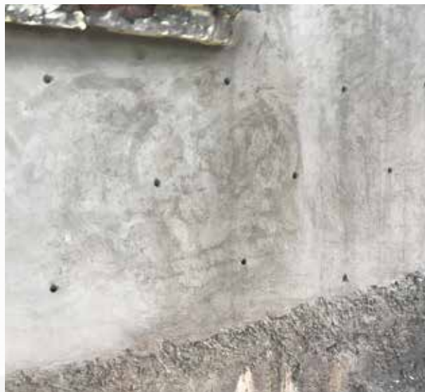
Усиление кирпичных стен с применением материала «Скрепа М600»
