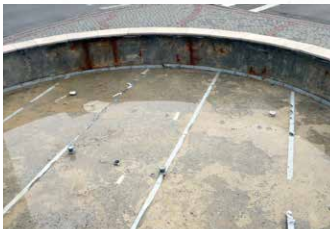
До начала работ
