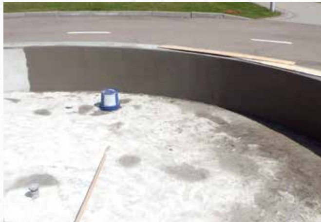
По окончании работ
