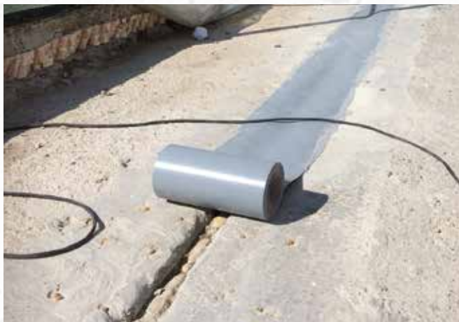
По окончании работ
