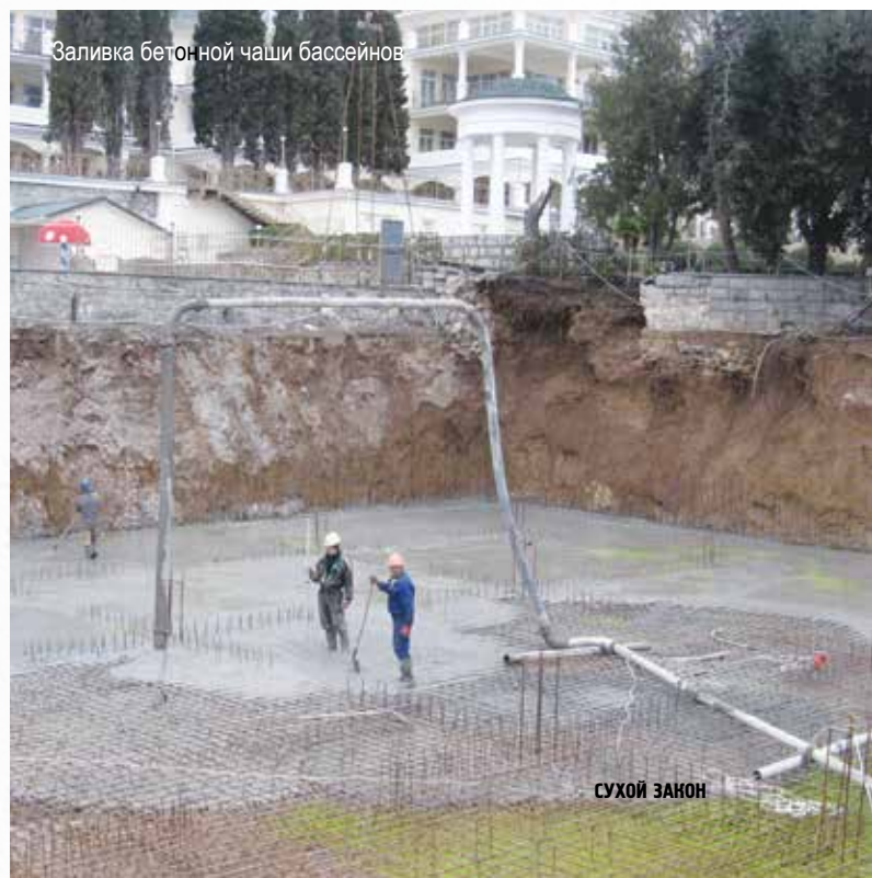
Организация процесса бетонирования
