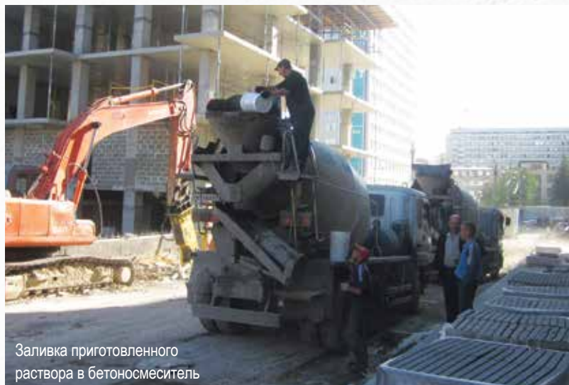
Процесс приготовления раствора материала «Пенетрон Адмикс»
