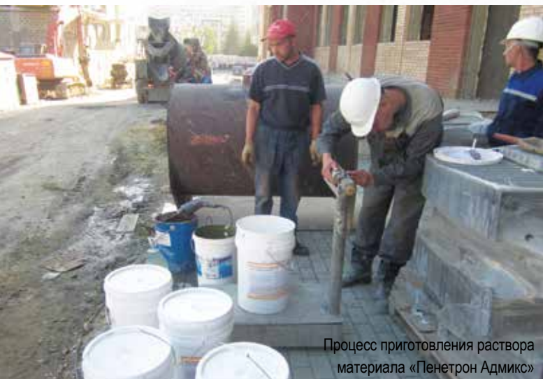
Заливка приготовленного раствора в бетономеситель
