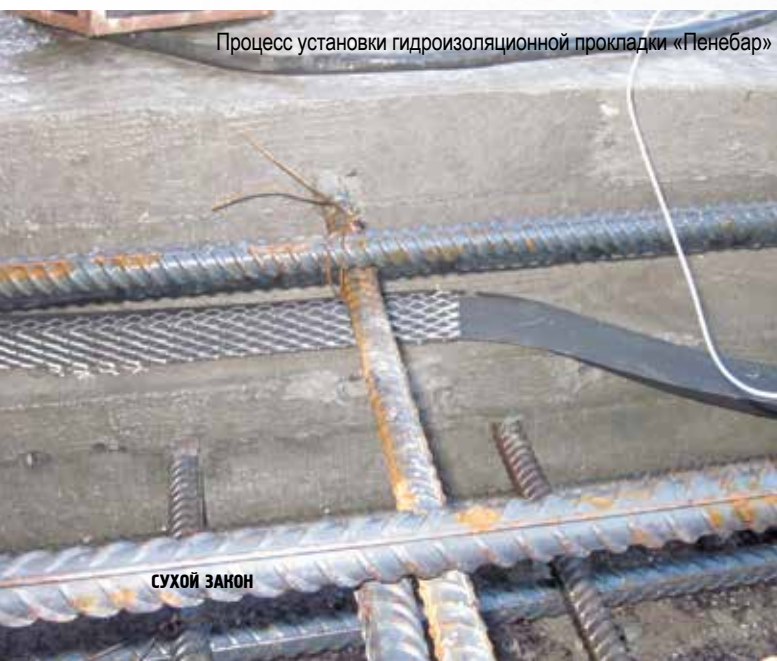
Установка прокладки «Пенебар» завершена
