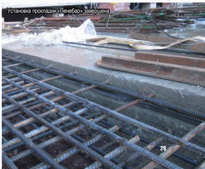
Процесс установки гидроизоляционной прокладки «Пенебар»
