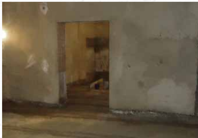
По окончании работ
