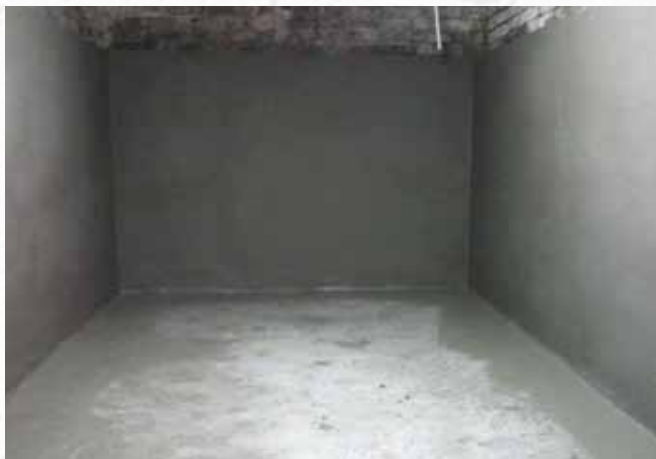
По окончании работ
