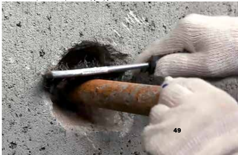
Рис. 6. Общий вид штрабы вокруг трубы
