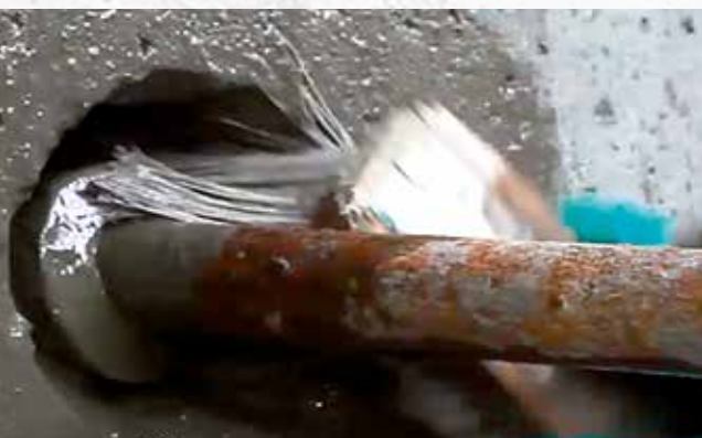
Рис. 9. Увлажнение и обработка поверхности бетона раствором смеси «Пенетрон»
