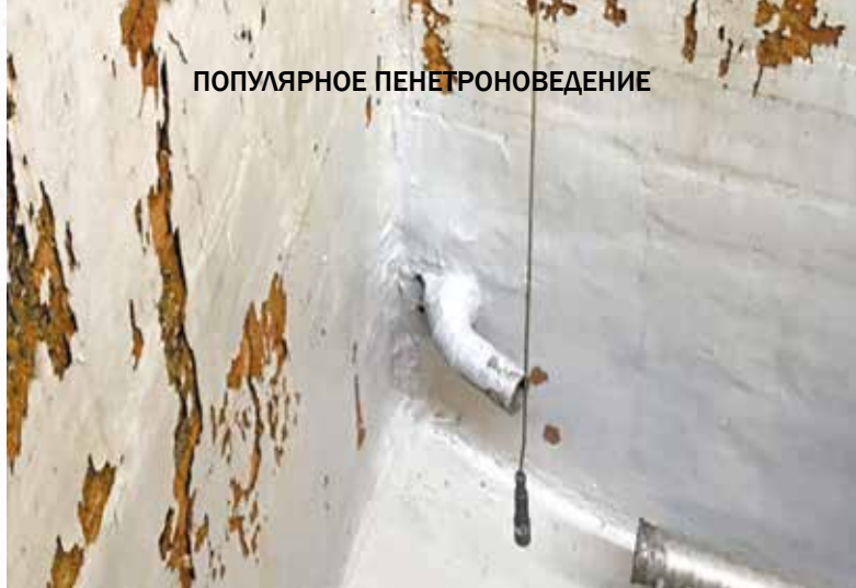
Рис. 4. Место ввода трубопровода
