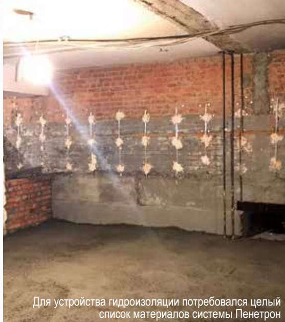
Гидроизоляционные работы в подвальных помещениях частной школы
