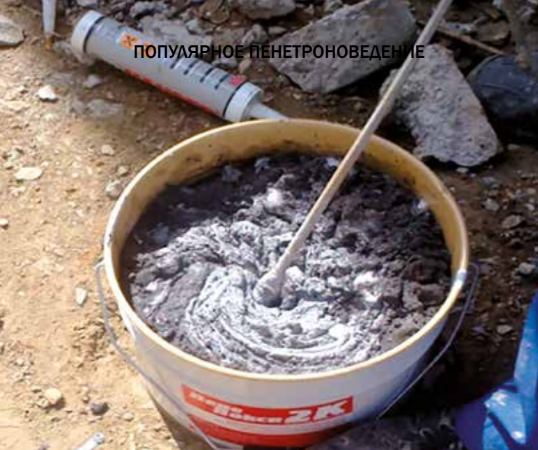
Рис. 16. Приготовление «ПенеПокси 2К»
