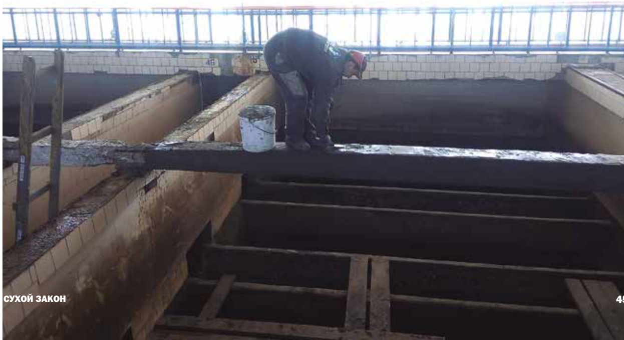
Восстановление железобетонных балок скорого фильтра материалом «Скрепа М700 Конструкционная»
