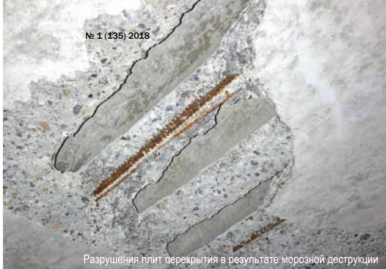
Плита перекрытия до начала восстановительных работ
