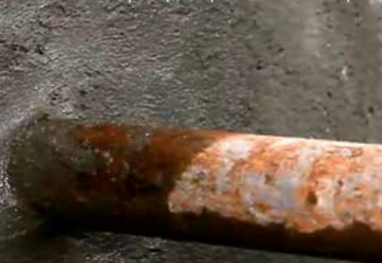
Рис. 10. Заполнение штрабы раствором смеси «Пенекрит»
