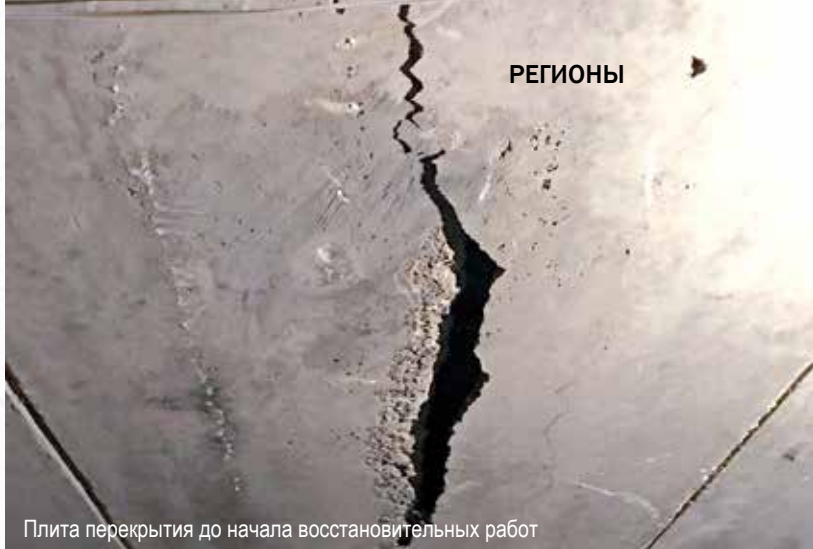
Разрушения плит перекрытия в результате морозной деструкции
