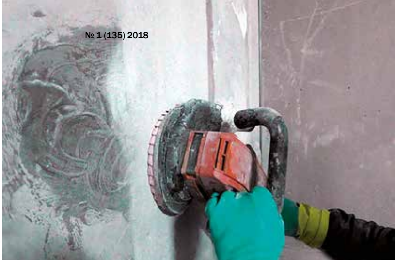
Рис. 3. Очистка поверхности
