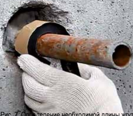
Рис. 7. Определение необходимой длины жгута «Пенебар»
