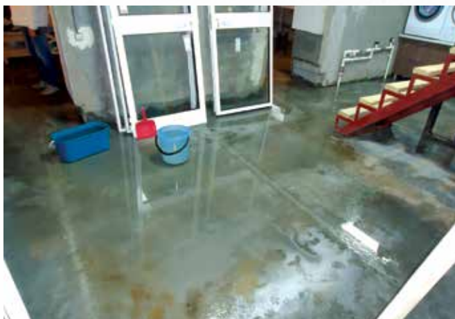
До начала работ
