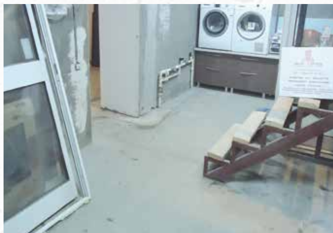
По окончании работ
