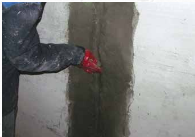
По окончании работ
