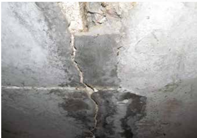
До начала работ
