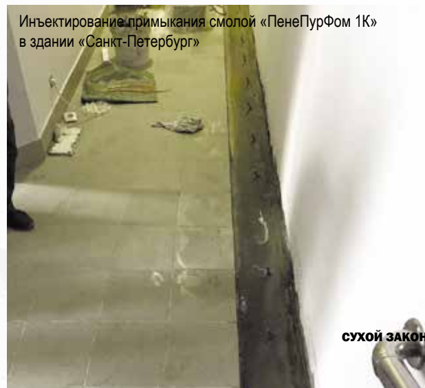
Демонтаж декоративного покрытия в местах протечек
