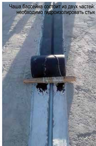
Стык герметизируется с помощью системы Пенебанд С
