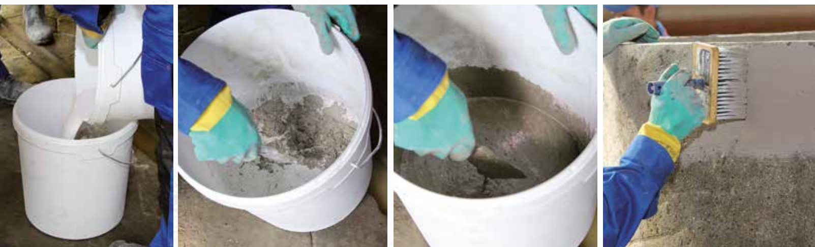
Приготовление и нанесение растворной смеси «Скрепа 2К Эластичная»
