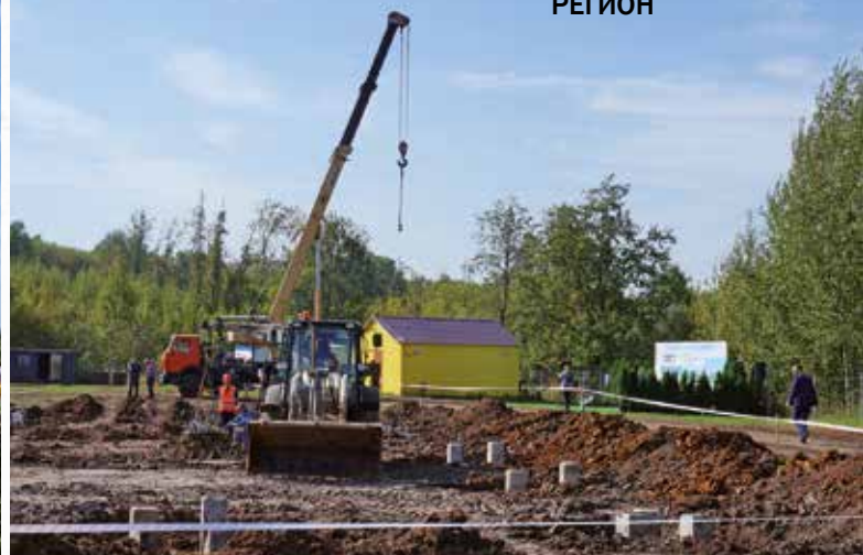
Бассейны для зарыбления будут гидроизолированы Пенетроном
