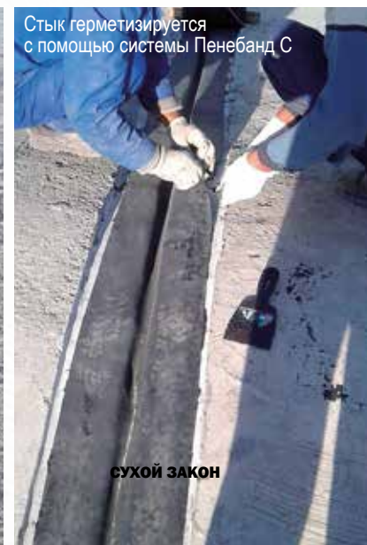
Чаша бассейна состоит из двух частей: необходимо гидроизолировать стык
