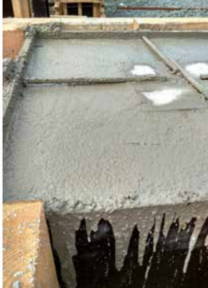
Бетонирование с добавкой «Пенетрон Адмикс»
