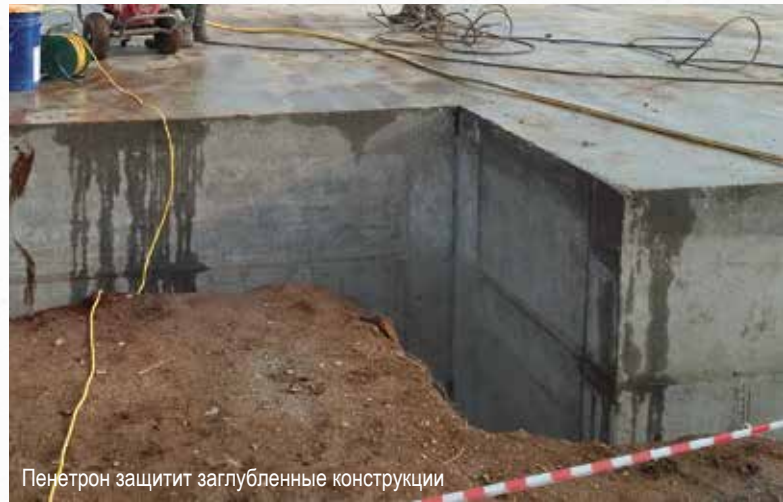
Бетонирование с добавкой «Пенетрон Адмикс»
