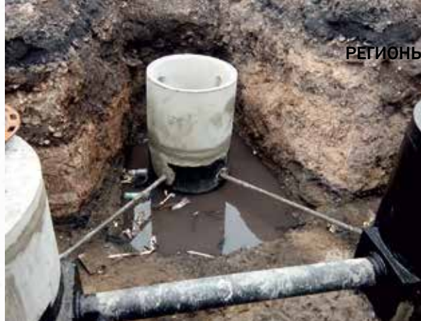
Колодцы водопровода спринклерной системы пылеподавления
