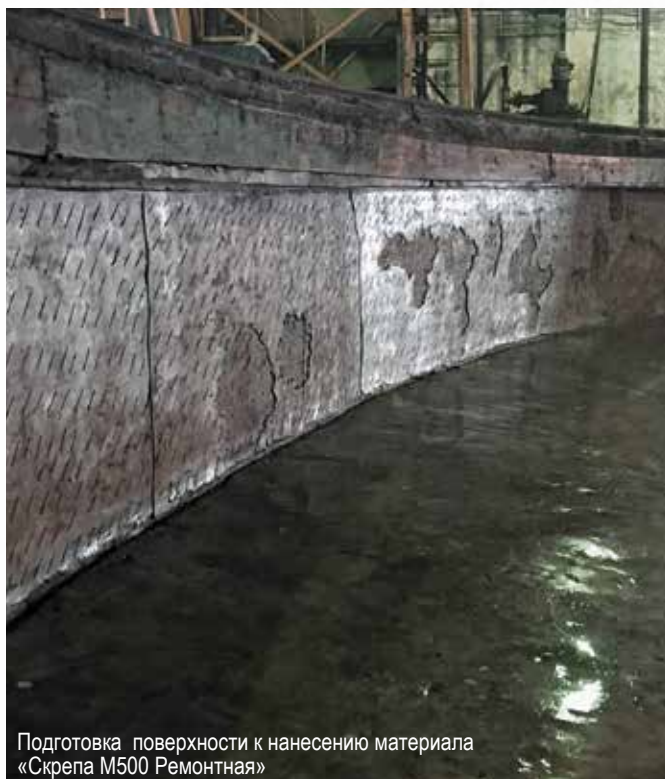
Нанесение материала «Скрепа М500 Ремонтная»
