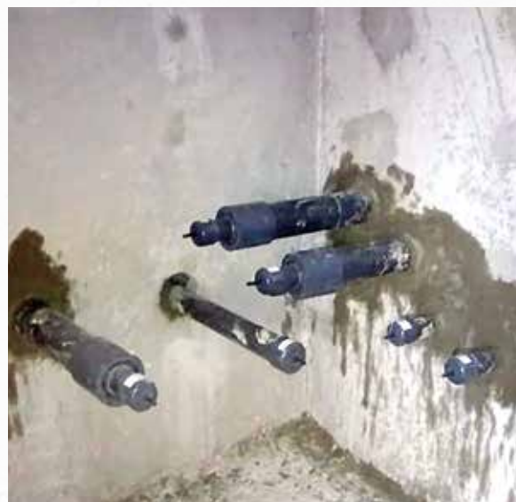
На объекте герметизировано около 50 вводов и выводов коммуникаций
