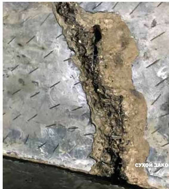
Дефекты бетона чаши радиального сгустителя
