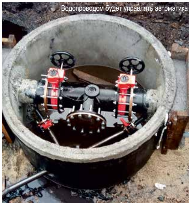
Все колодцы на линии защищены от воды по технологиям Пенетрон
