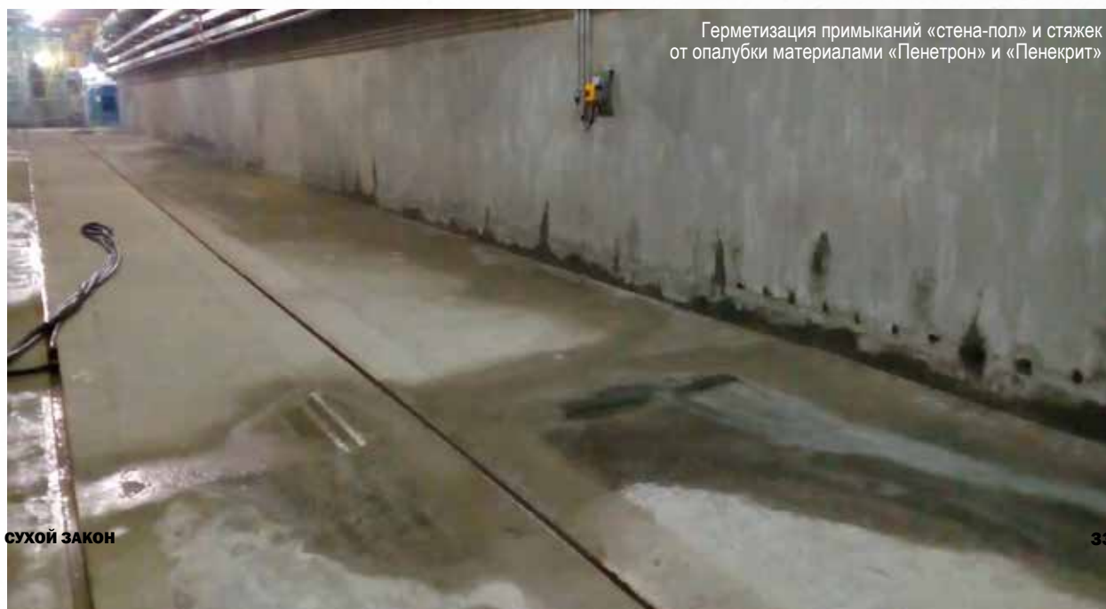
Герметизация деформационного шва системой ПенеБанд С
