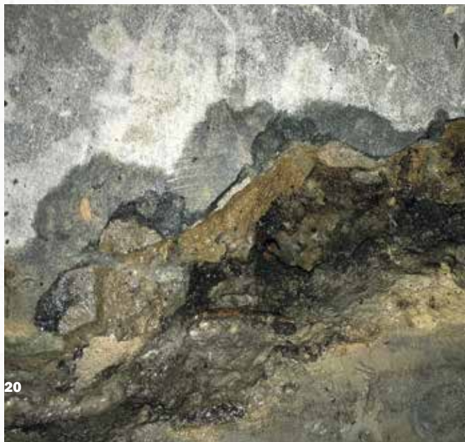
Дефекты бетона чаши радиального сгустителя
