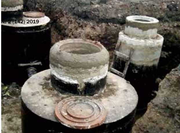
Колодцы водопровода спринклерной системы пылеподавления
