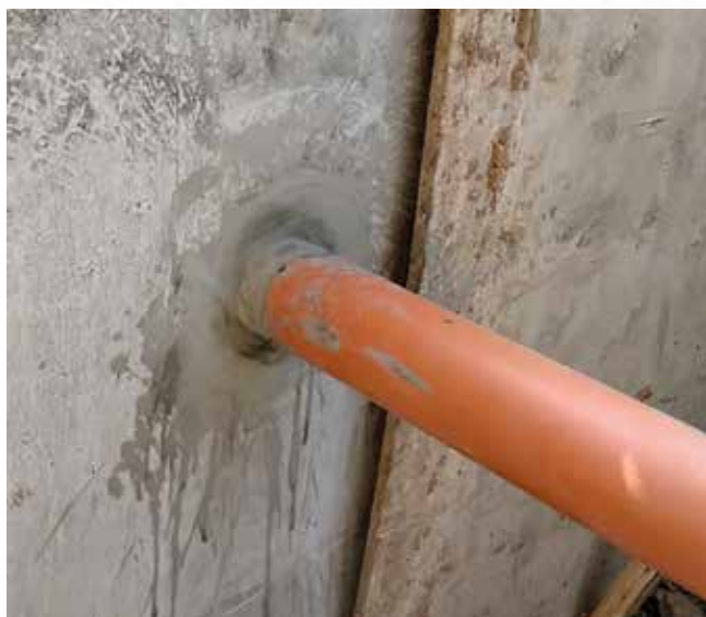
На объекте герметизировано около 50 вводов и выводов коммуникаций
