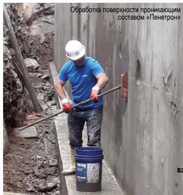
Герметизация технологических швов
