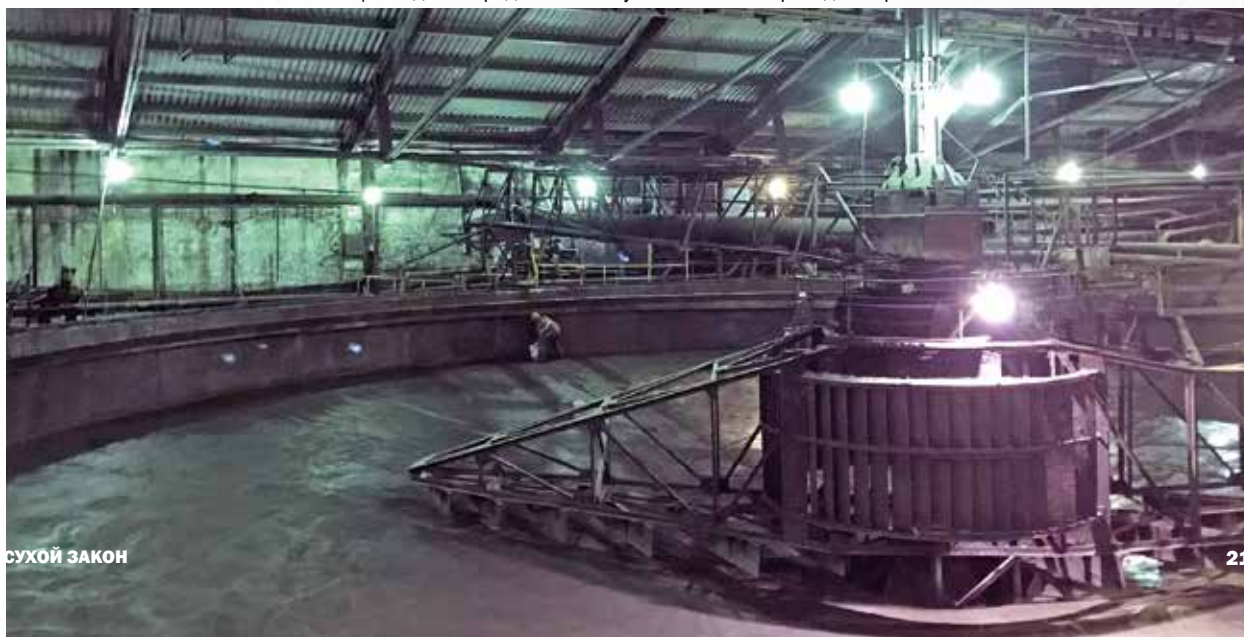
Общий вид чаши радиального сгустителя после проведения работ
