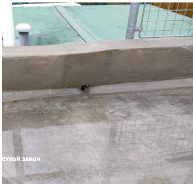
Финишная обработка – проникающим составом «Пенетрон»
