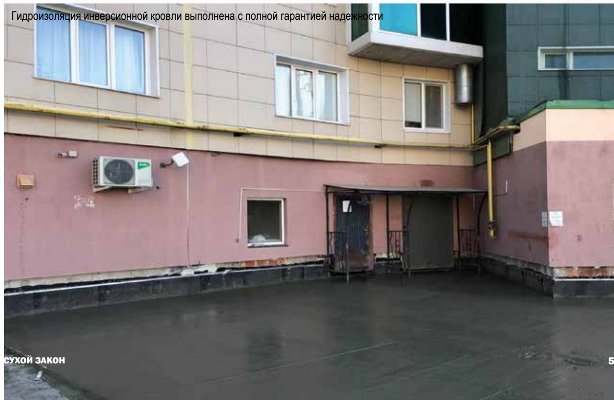
Идет заливка бетона с добавкой «Пенетрон Адмикс»
