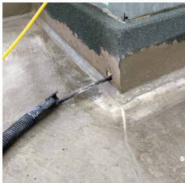
Финишная обработка – проникающим составом «Пенетрон»
