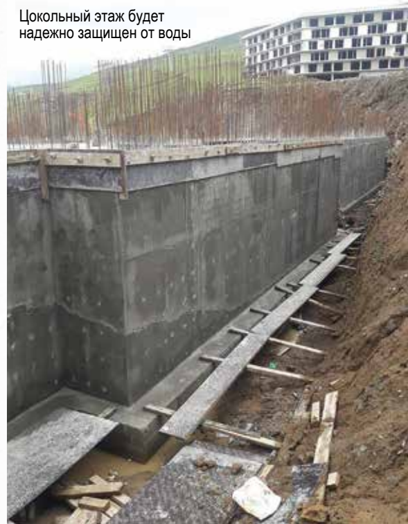
Обработка поверхности проникающим составом «Пенетрон»
