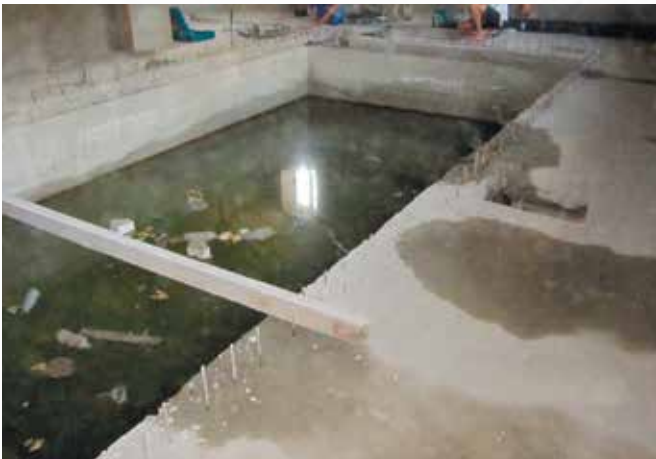
До начала работ
