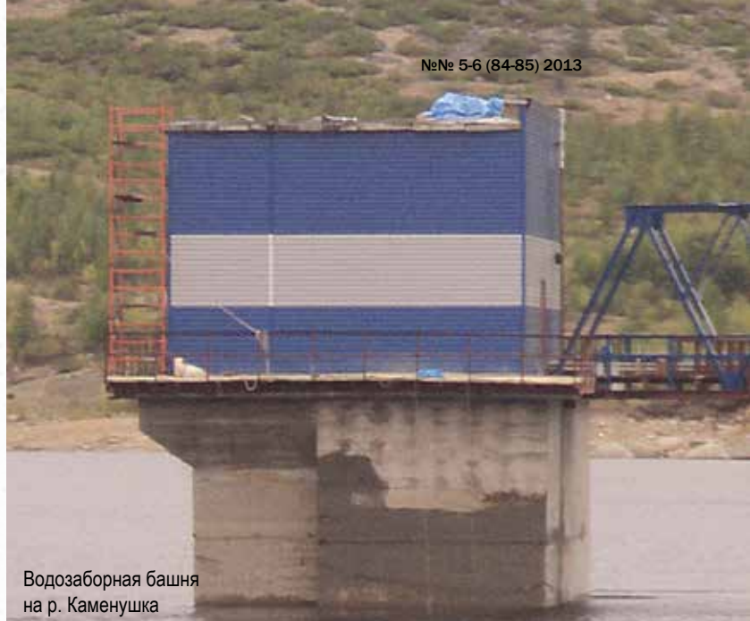
Выполнение гидроизоляционных работ промышленными альпинистами
