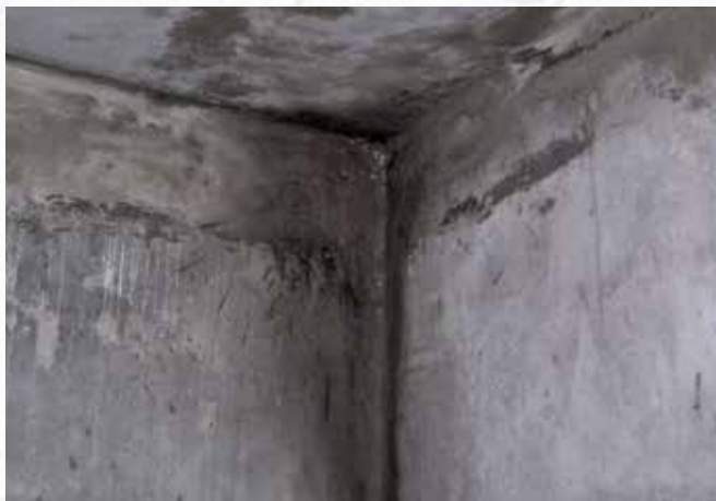
По окончании работ
