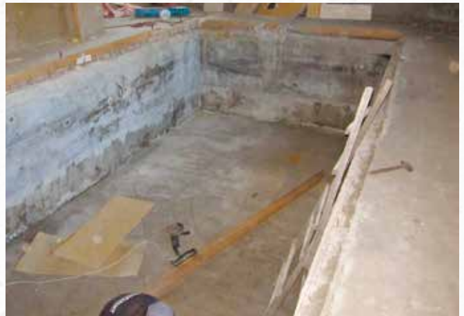
По окончании работ
