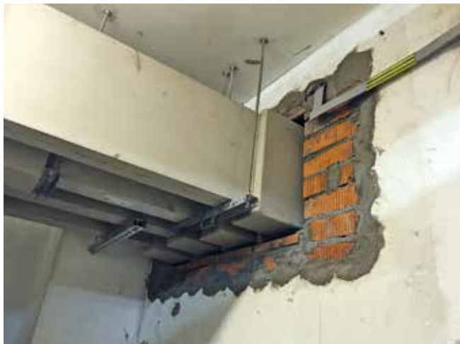
Герметизация технологического проема с коммуникациями: до и после обработки
