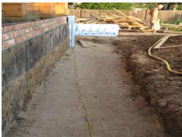
Рис. 3. Укладка песка под отмостку
