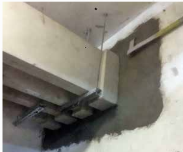
Герметизация технологического проема с коммуникациями: до и после обработки
