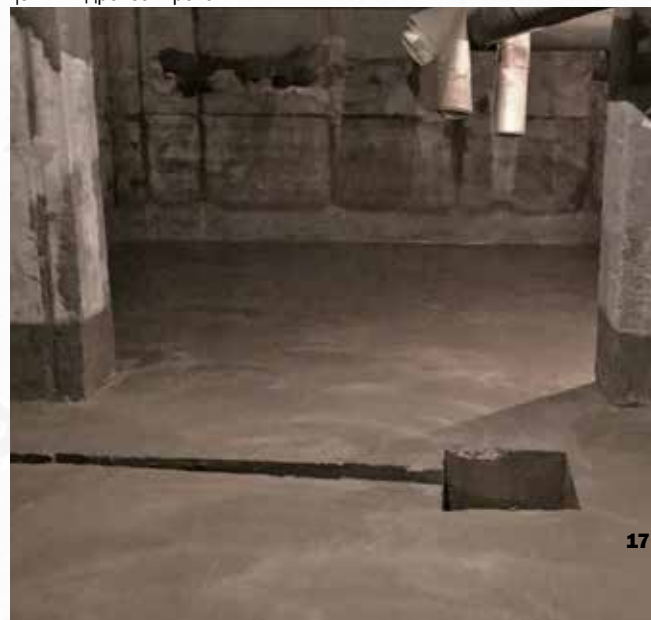
Заглубленные помещения гидроизолированы
