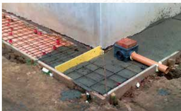
Рис. 9. Укладка бетонной смеси в опалубку
