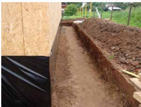
Рис. 2. Траншея под отмостку
