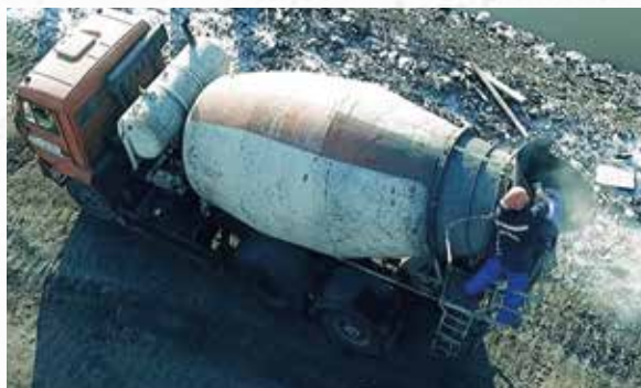
Рис. 8. Введение добавки «Пенетрон Адмикс» в автобетоновоз
