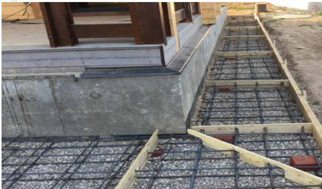
Рис. 6. Пример армирования отмостки
