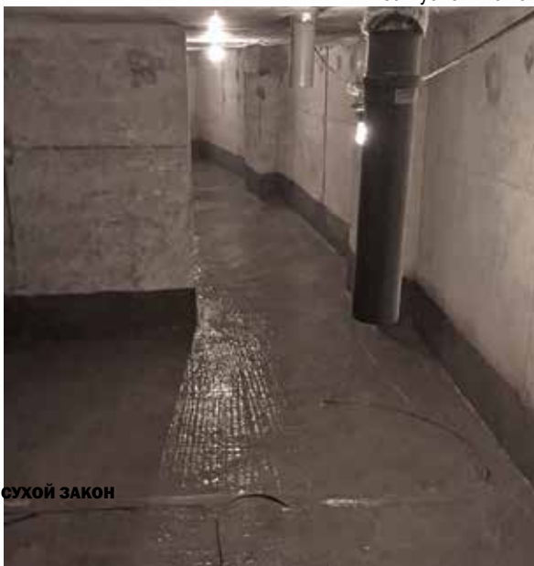
Заглубленные помещения гидроизолированы
