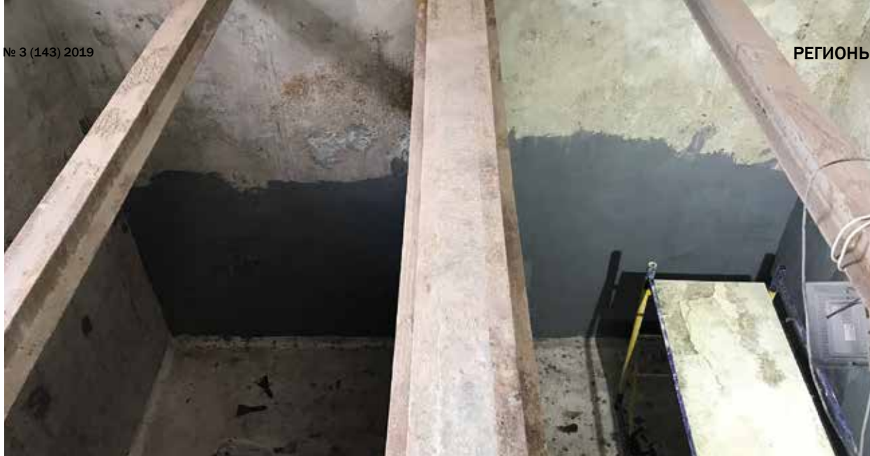
Нанесение эпоксидного состава «ПенеПокси 2К»
