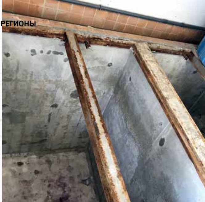
Емкости для хранения реагентов на КОС «Акатово»: подготовительный этап гидроизоляционных работ
