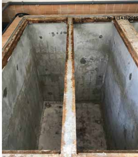
Емкости для хранения реагентов на КОС «Акатово»: подготовительный этап гидроизоляционных работ
