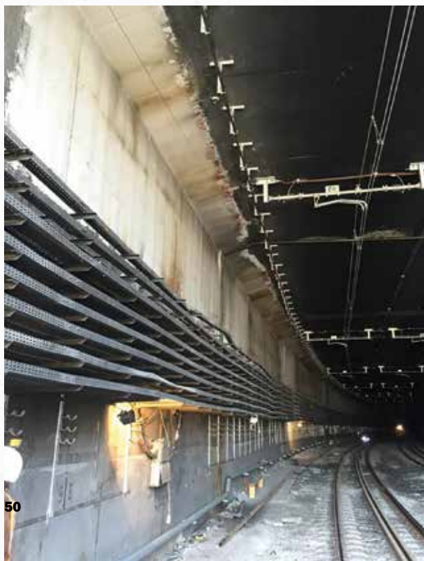
Протечки на стенах и сводах тоннеля вблизи контактной сети
