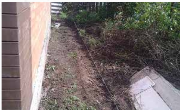
Рис. 1. Разметка под отмостку
