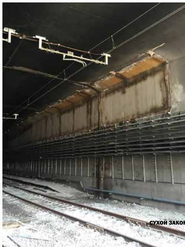
Протечки на стенах и сводах тоннеля вблизи контактной сети
