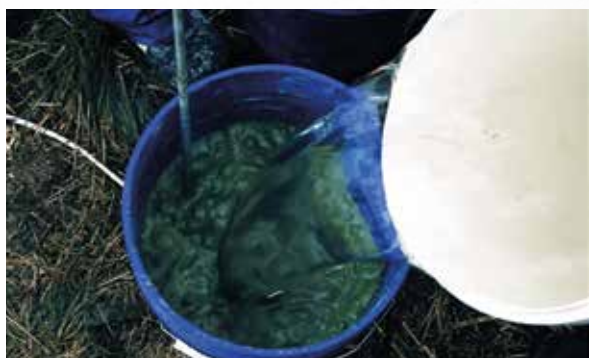
Рис. 7. Приготовление раствора гидроизоляционной добавки «Пенетрон Адмикс»
