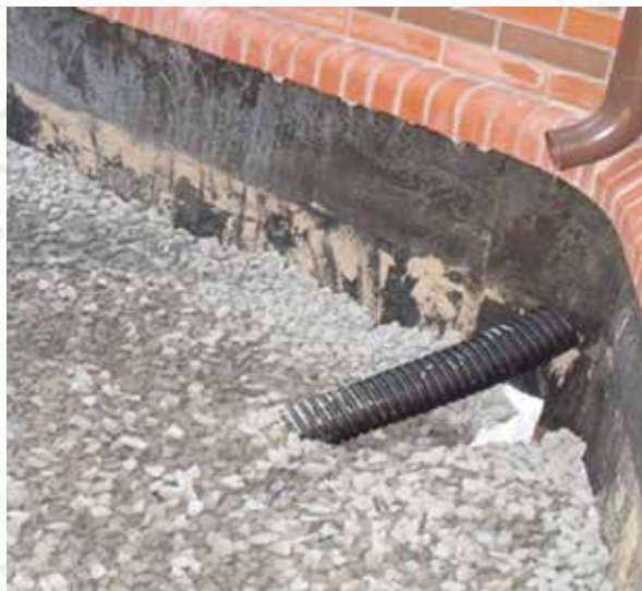
Рис. 4. Укладка щебня под отсыпку
