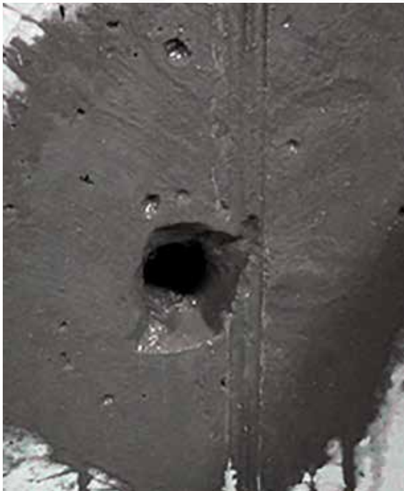
Рисунок 9 - Увлажнение отверстия
