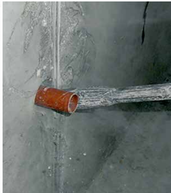
Рисунок 8 - Удаление пластиковой втулки
