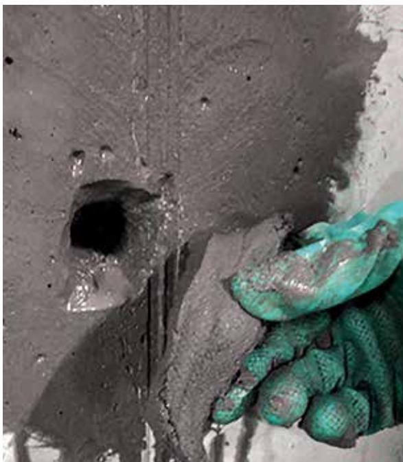
Рисунок 10 - Заполнение отверстия
