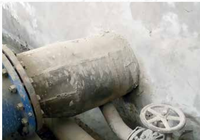
По окончании работ
