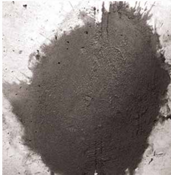
Рисунок 11 - Общий вид отверстия после выполнения гидроизоляционных работ
