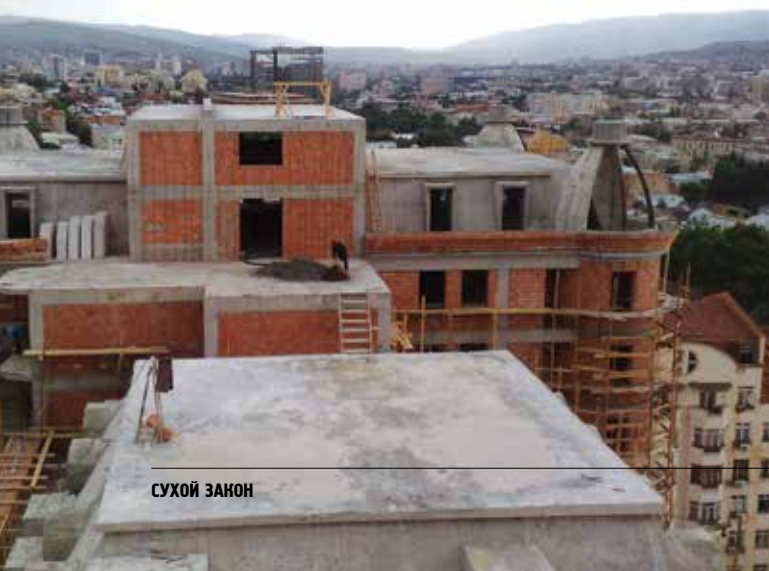
Гидроизоляция пентхауса «Руставели резиденс»
