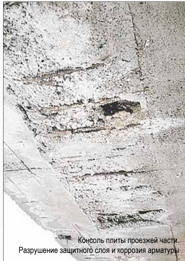
Разрушение защитного слоя бетона и коррозия арматуры тротуарной консоли
