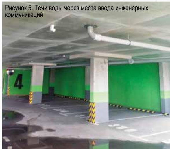
Рисунок 5. Течи воды через места ввода инженерных коммуникаций
