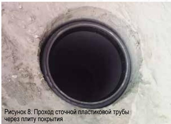
Рисунок 8. Проход сточной пластиковой трубы через плиту покрытия
