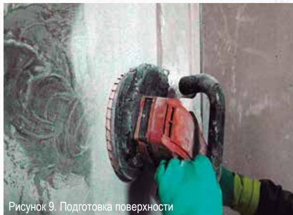
Рисунок 9. Подготовка поверхности
