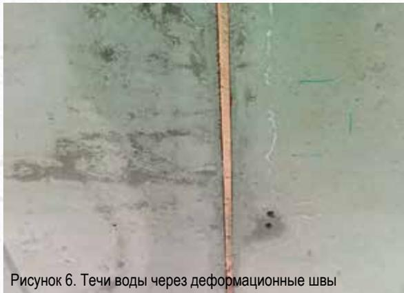
Рисунок 6. Течи воды через деформационные швы
