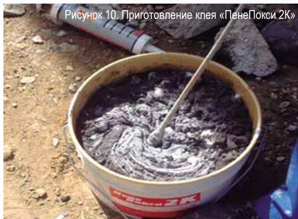
Рисунок 10. Приготовление клея «ПенеПокси 2К»
