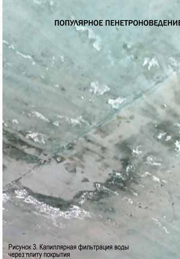
Рисунок 3. Капиллярная фильтрация воды через плиту покрытия
