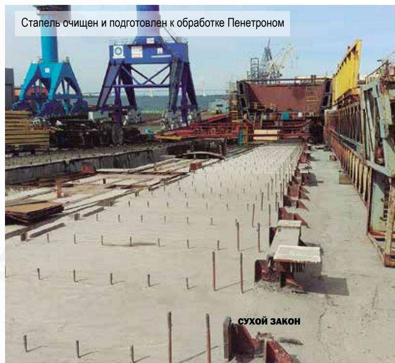
Стапель очищен и подготовлен к обработке Пенетроном
