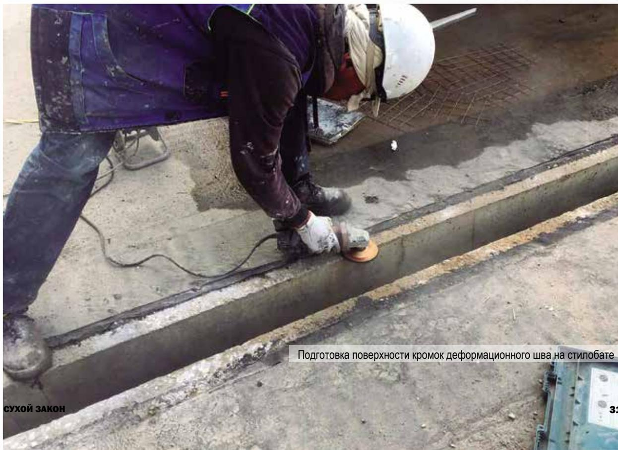
Подготовка поверхности кромок деформационного шва на стилобате
