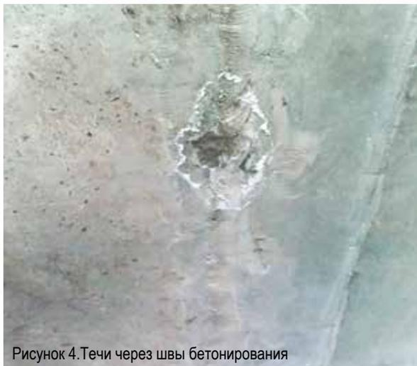
Рисунок 4. Течи через швы бетонирования
