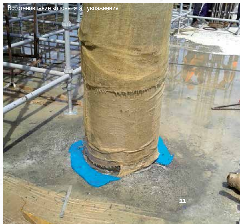
Восстановление несущей способности колонн: материал «Скрепа М500 Ремонтная»
