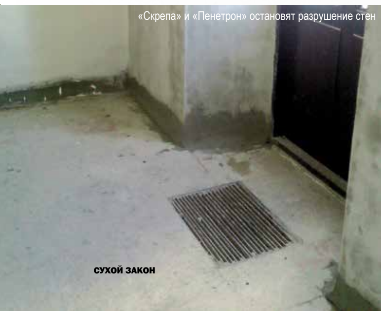
Лотковая железобетонная кровля восстановлена с помощью материалов «Скрепа» и «Пенетрон»
