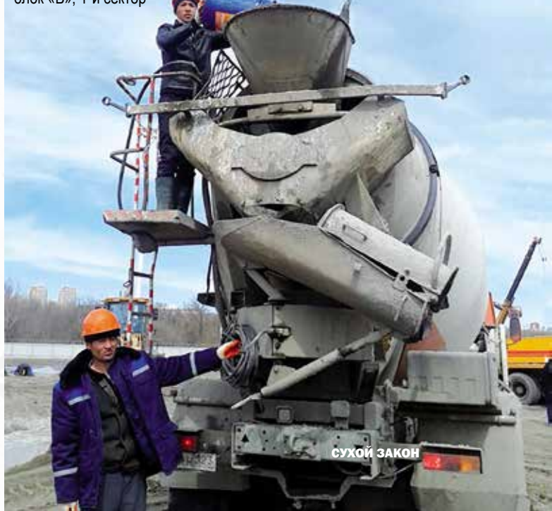
Заливка ростверка фундамента, введение добавки в бетон «Пенетрон Адмикс»: блок «Б», 1-й сектор
